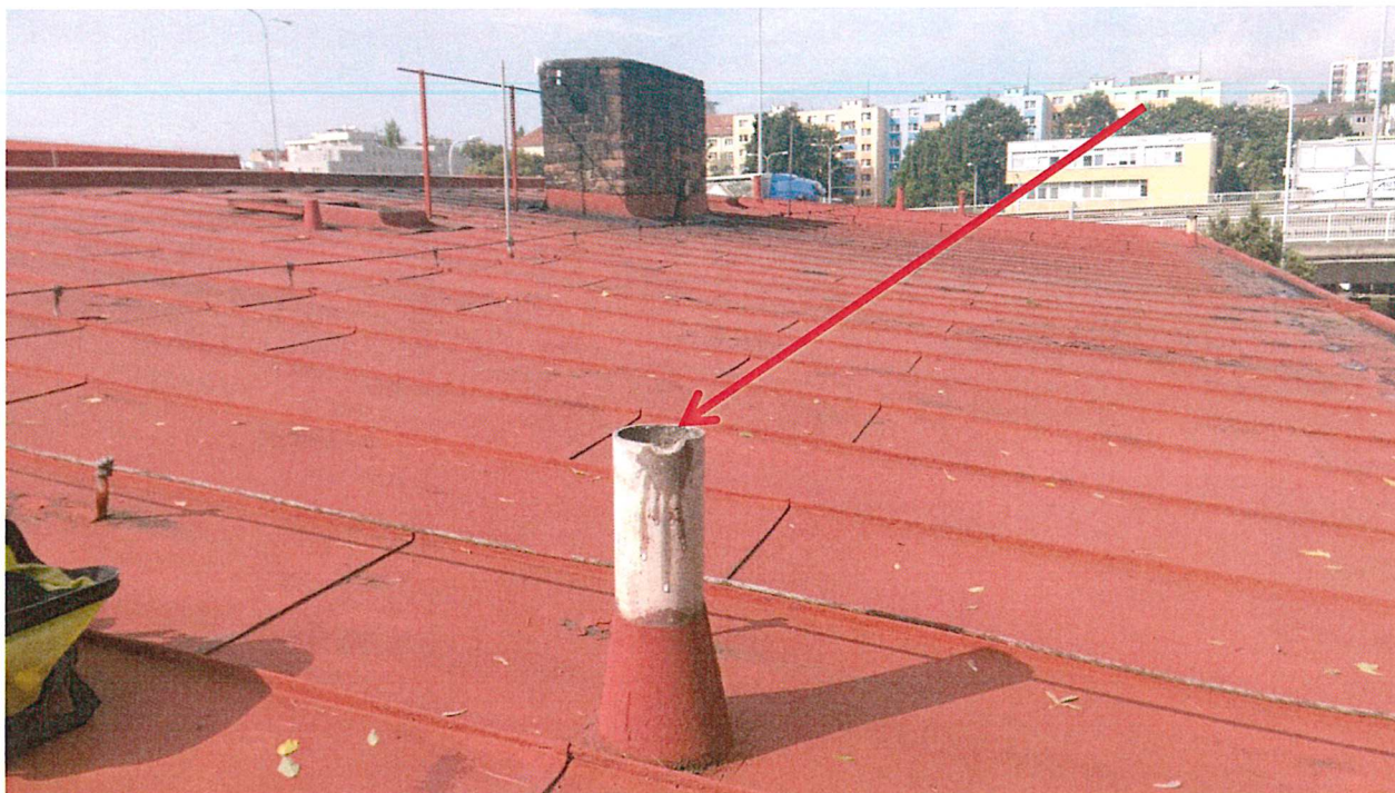
Foto č. 4 - Lokalizace místa odběru vzorku č. 1 . Budova dílny a pronájmy, pultová střecha. Azbestocementová roura jako kanalizační stoupačka.
