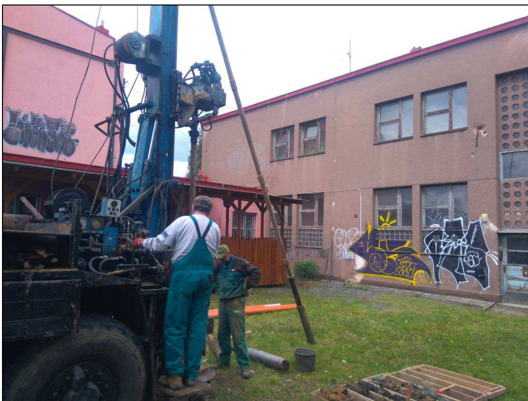
Obr. č. 8 - provádění jádrového vrtu J1/VB
