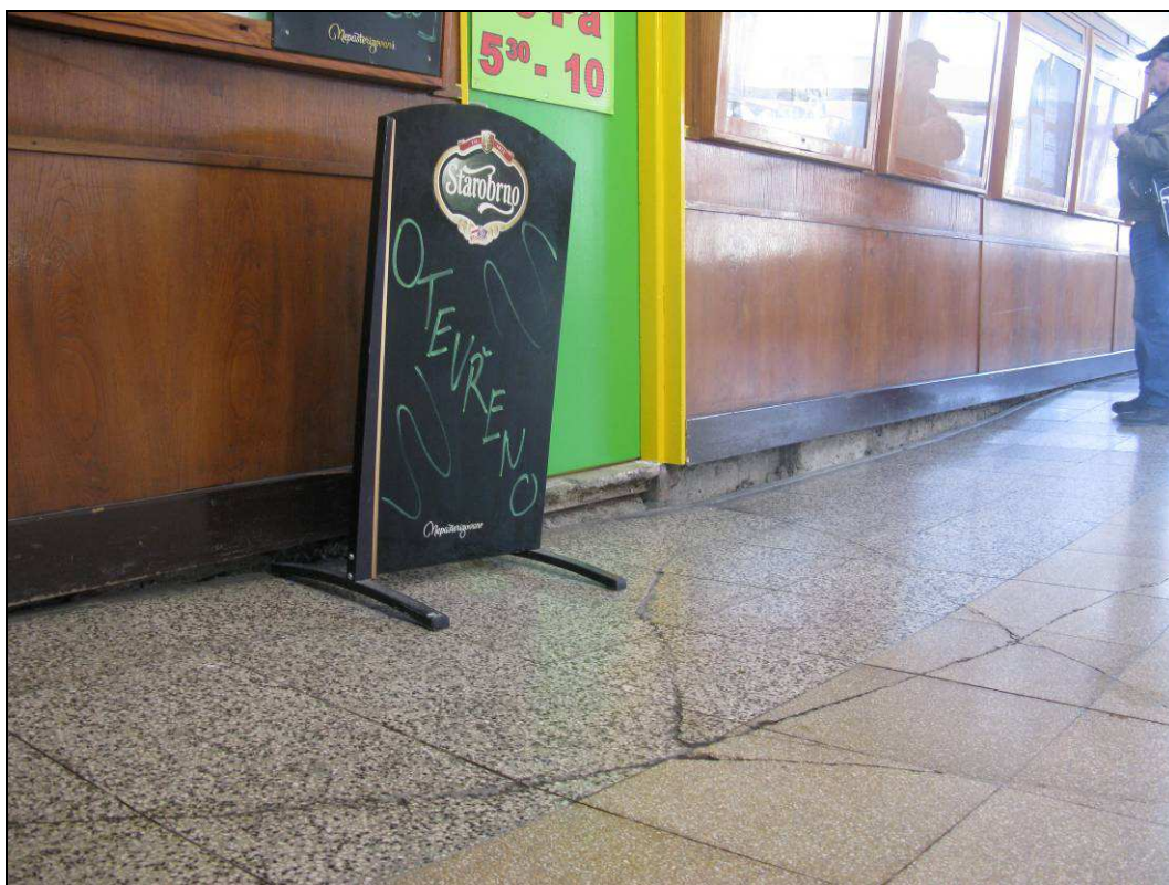
Obr. č. 6 - prosedlá podlaha ve výpravní hale u vstupu do nádražní restaurace
