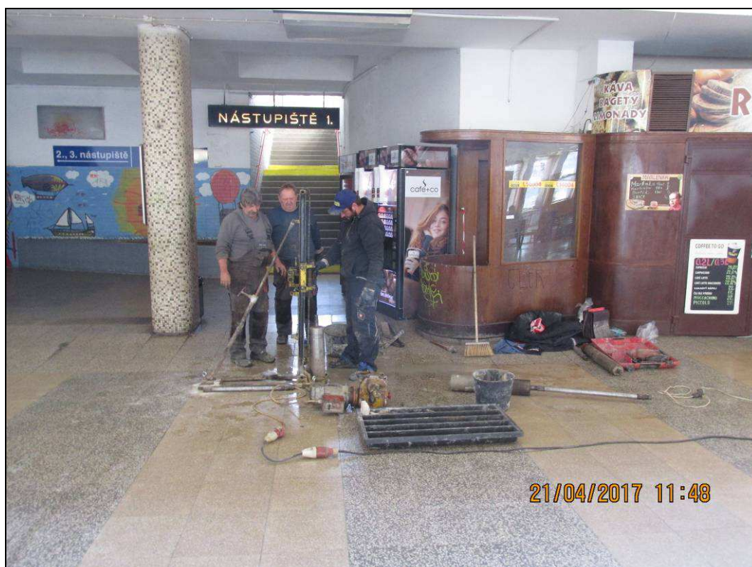
Obr. č. 7 - provádění vrtných prací uvnitř výpravní haly
