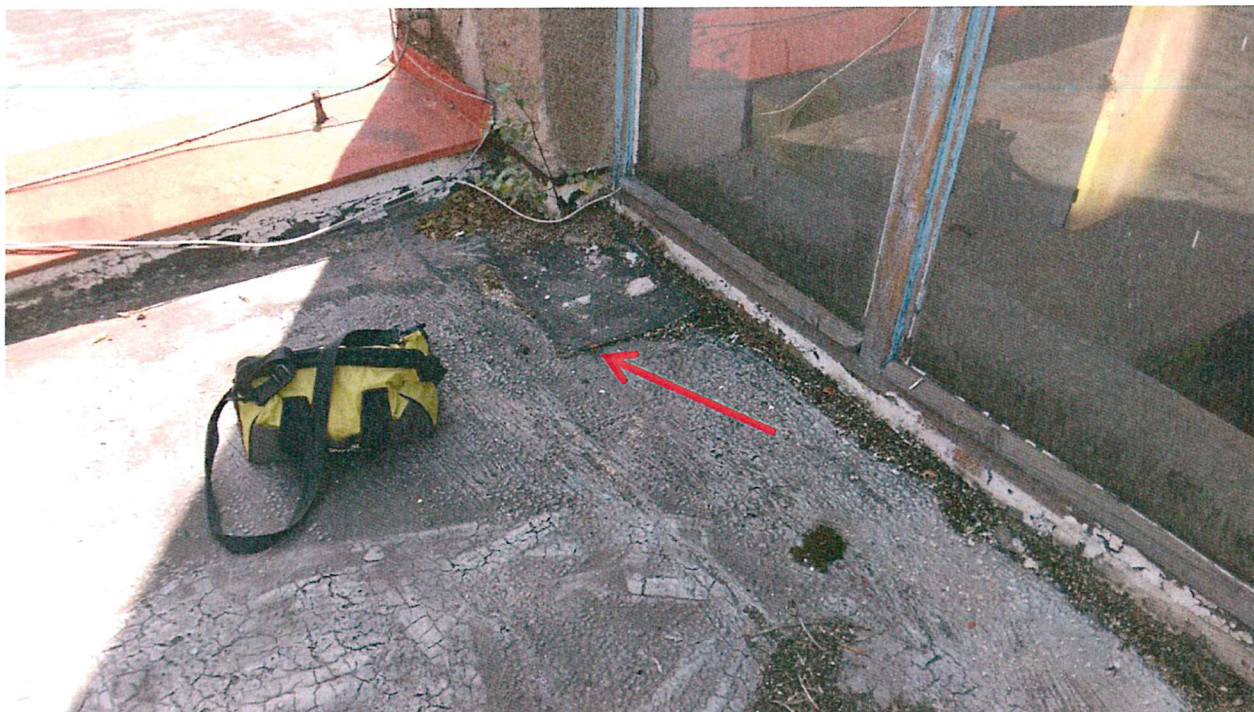
Foto č. 9 - Lokalizace místa odběru vzorku č. 7 . Odbavovací hala, střecha nad hospodou, část u nástupiště č. 1. Azbestové souvrství asfaltových lepenek jako střešní krytina.
