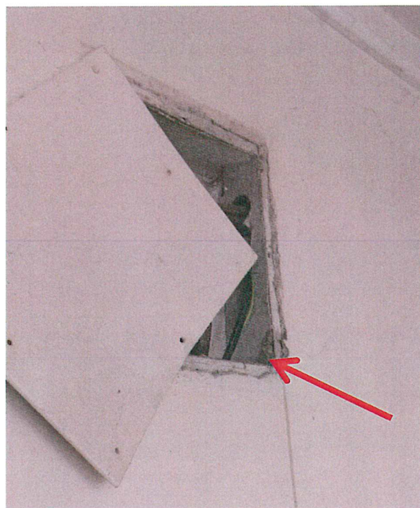
Foto č. 6 - Lokalizace místa odběru vzorku č. 3 . Technická budova SSZT, 2.NP, chodba. Azbestová obkladová deska uvnitř elektrorozvodné skříně ve zdi.
