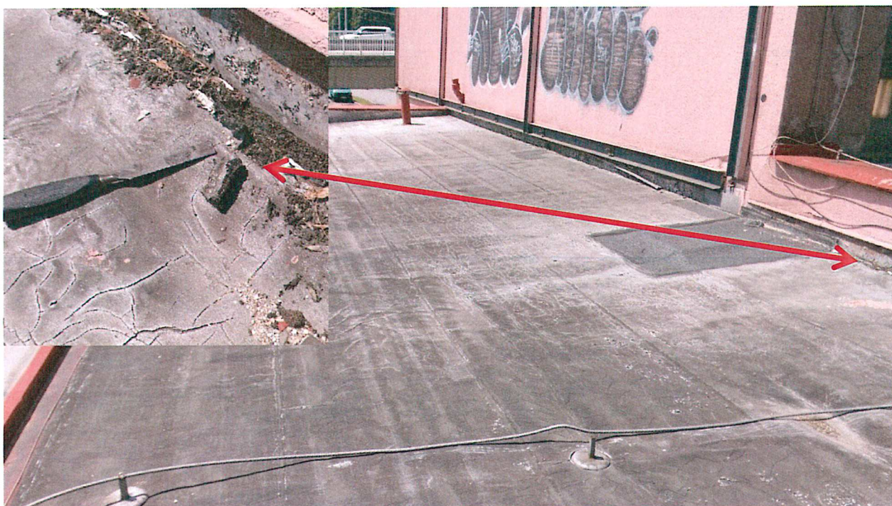
Foto č. 10 - Lokalizace místa odběru vzorku č. 8 . Odbavovací hala, střecha nad hospodou, část u technické budovy SSZT. Azbestové souvrství asfaltových lepenek jako střešní krytina.
